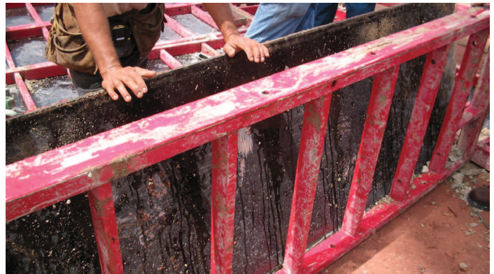
Cambio de tablero fenólico.
