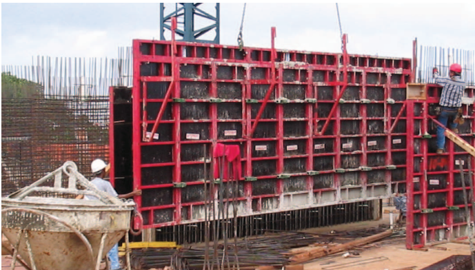
Manipulación de un muro de 24 mtrs cuadrados.
