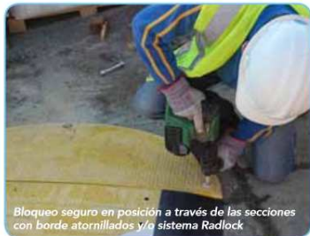
Las placas encajan de forma segura con el entrelazado de alto rendimiento
